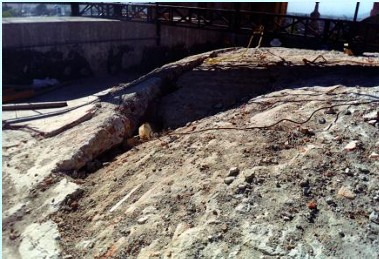
Daño exterior en bóveda.
