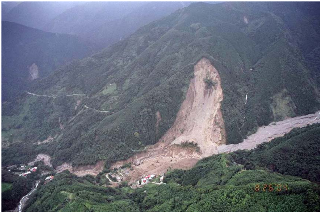
(圖 2)發生於艾利颱風之土場大山崩即為第 2 類非順層型深層快速滑動，造成土場部落遭土石掩埋，居民 15 人罹難。
