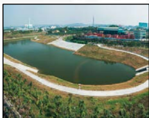
(6)獅龍溪滯洪池
