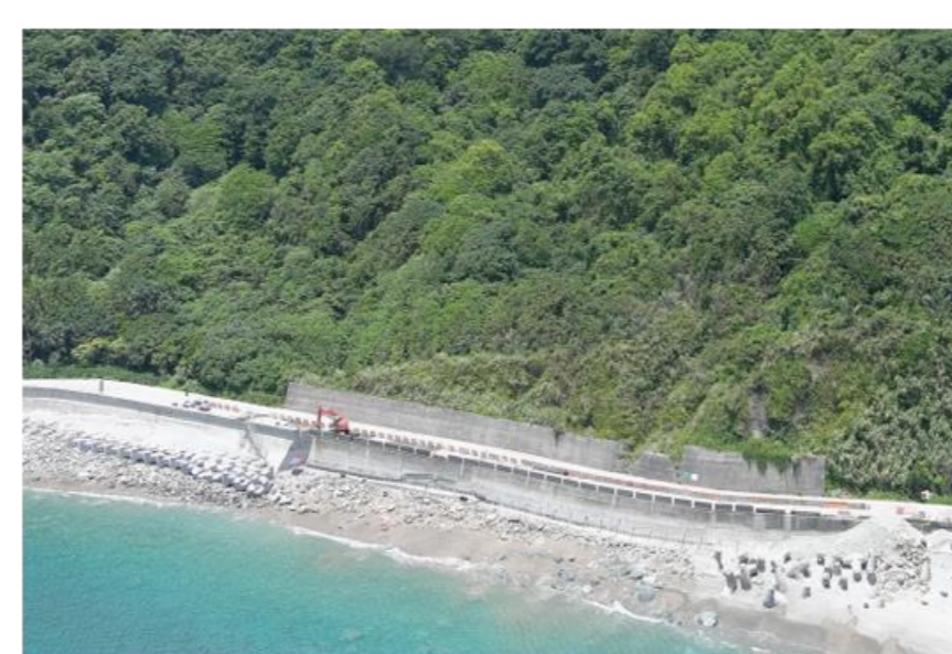
路基淘刷修復工程
